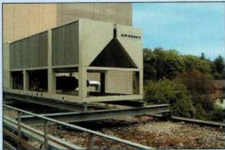
Die Kältemaschine wurde platz sparend auf dem Dach der Mälzerei montiert
