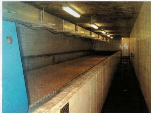
Die gleichmäßige Kühlung innerhalb der Keimkästen in, unter und über der Horde ermöglichen optimale Bedingungen
